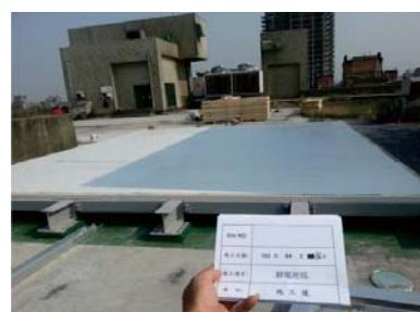
我們的鋼構基座可負荷的乘載能力為1.6T/M之平均載重3T之集中載重。
