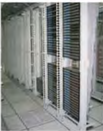
開放式機架加裝左右金屬鋁線槽範例
