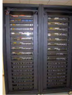
垂直線槽配線實例
