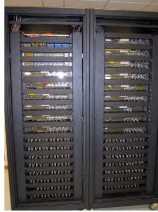
垂直線槽配線實例
